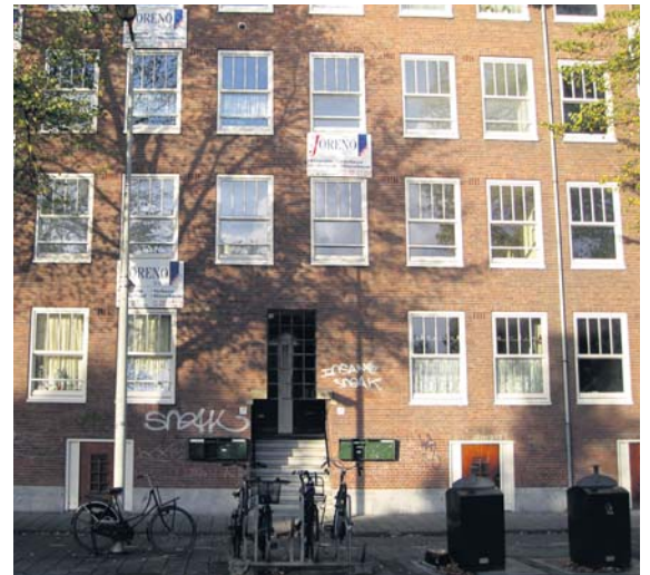
Grootscheepse renovatie aan de Willem de Zwijgerlaan
